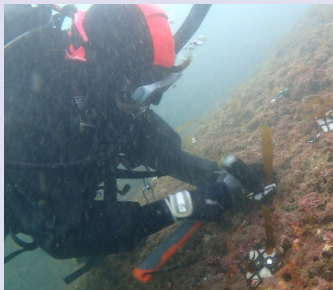
■ダイバーによる設置作業
